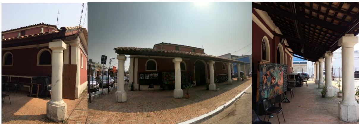
Figura 12a, b e c – Detalhes colunas que sustentam o alpendre. Fonte: Nathalia Gomes, 2019.
