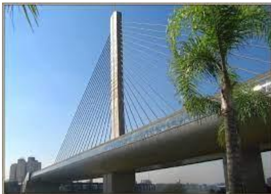
Figura 03: Ponte Estação Santo Amaro
