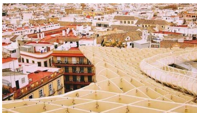
FIGURA 9: VISTA SUPERIOR DO METROPOL PARASOL
