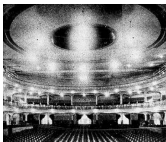
Figura 11 - Interior do edifício, 1922
