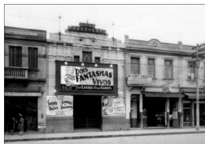
Figura 12 - Fachada Av. Celso Garcia
