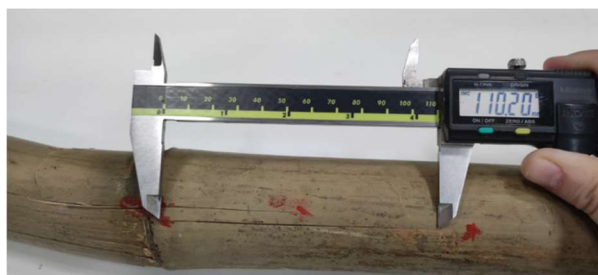
Figura 5. Medição de fissuras após ensaio com paquímetro eletrônico.
