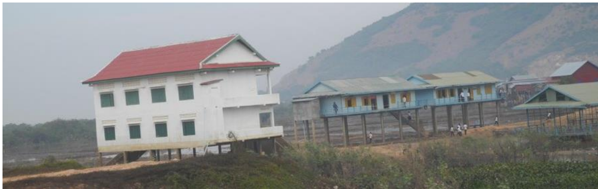
Fig. 05 - Casas sobre palafitas de alvenaria
