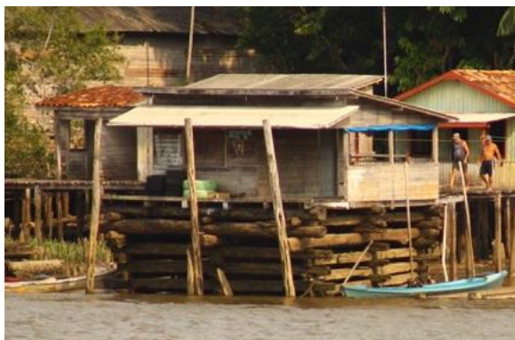
Figura 18 - Habitação no rio Furo Tajapuru estruturada por toras horizontais
