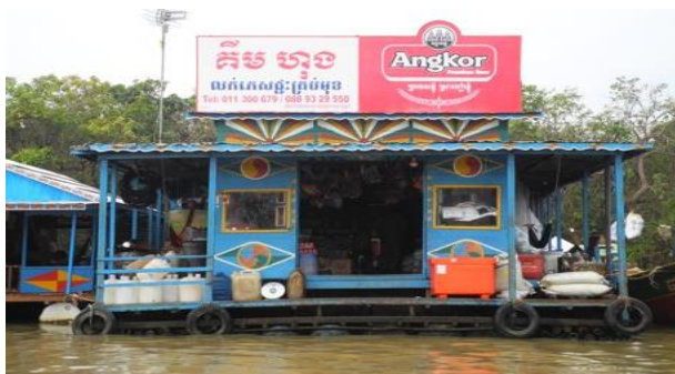
Fig. 06 - Construção comercial flutuante sobre galões de plástico
