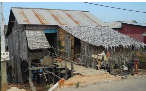
Fig. 02 - Casas sobre palafitas em área alagável próxima ao lago Tonle Sap, vista frontal (acesso à casa por meio de passarela)
