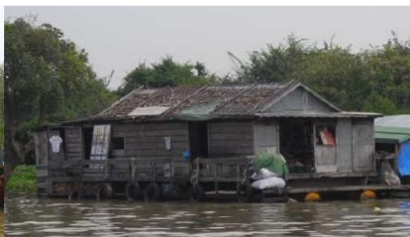
Fig. 07 - Habitação flutuante em madeira sobre tonéis metálicos
