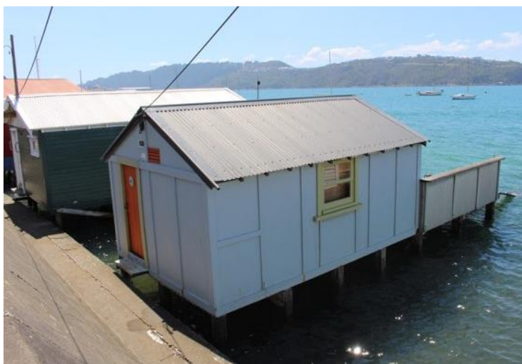
Fig. 11 - Casa sobre palafitas pré-fabricada em Evans Bay Parade, Wellington, Nova Zelândia.
