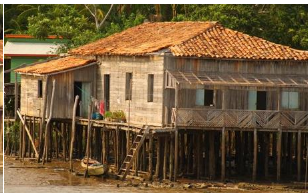
Figura 19 - Habitação no rio Furo Tajapuru estruturada por palafitas
