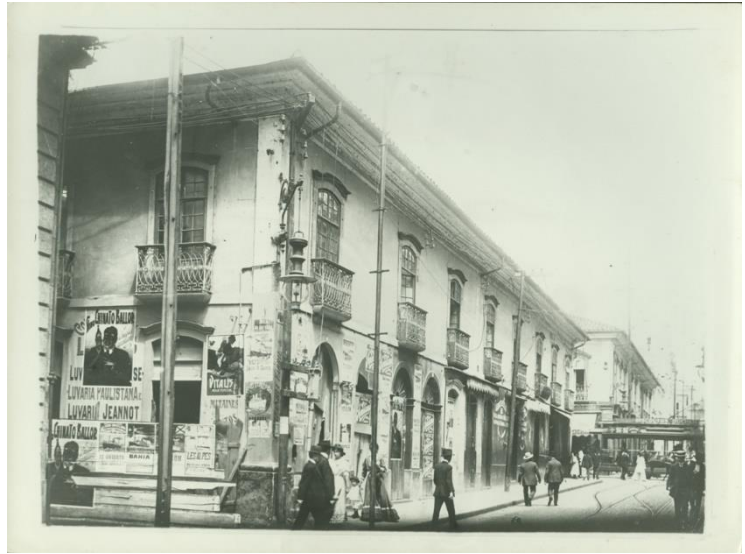
Fig. 28) Rua da Quitanda com Rua São Bento. 1911. Fonte: http://www.inci.org.br/acervodigital/pesquisalocalidade.php?paginafotografia=5020&id=fotografias&localidade=&inicio=&termino=
