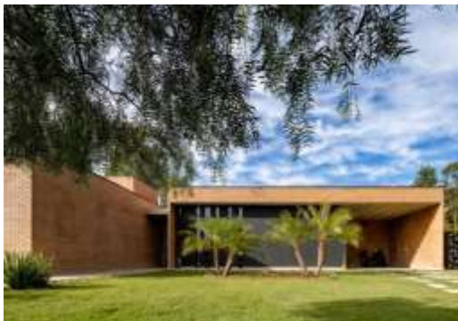
Figura 2 - Vista externa da Casa MP
