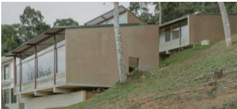
Figura 8 - Vista externa da residência
