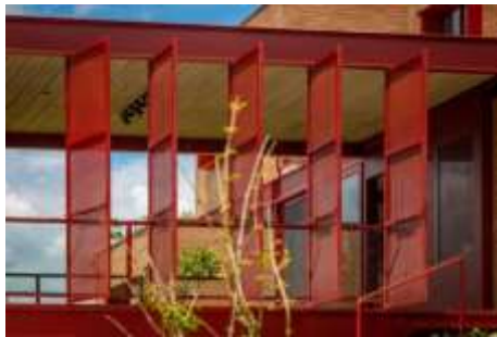
Figura 6 – Detalhes da fachada
