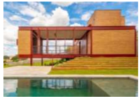
Figura 7 – Vista externa da casa
