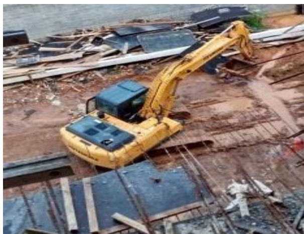
Figura 4: Descarte de resíduos empresa B- terceiro edifício
