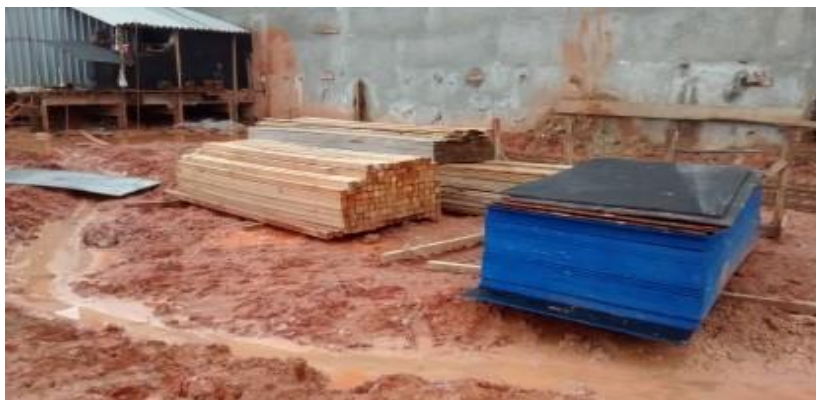
Figura 3: Descarte de resíduos empresa B- segundo edifício
