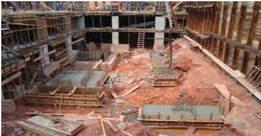
Figura 2: Descarte de resíduos empresa B- primeiro edifício
