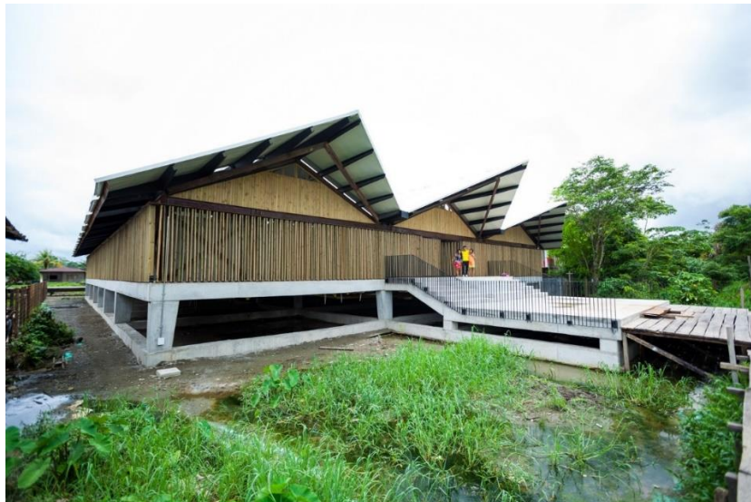
Figura 2: Fotografia da Instituição Embera, destacando as fundações em concreto.
