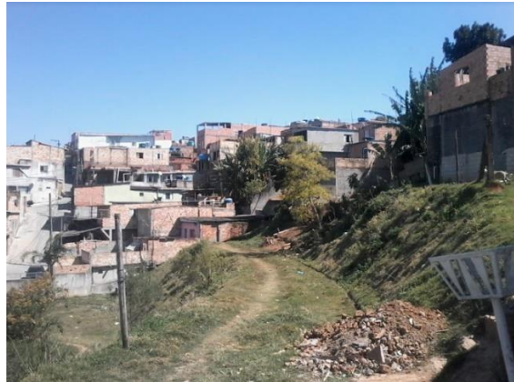
Figura 6: Ocupações em áreas de risco no Jardim Prainha. Fonte: Autora.
