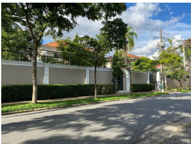
Figura 8: Foto do muro da residência localizada na Rua Honduras
