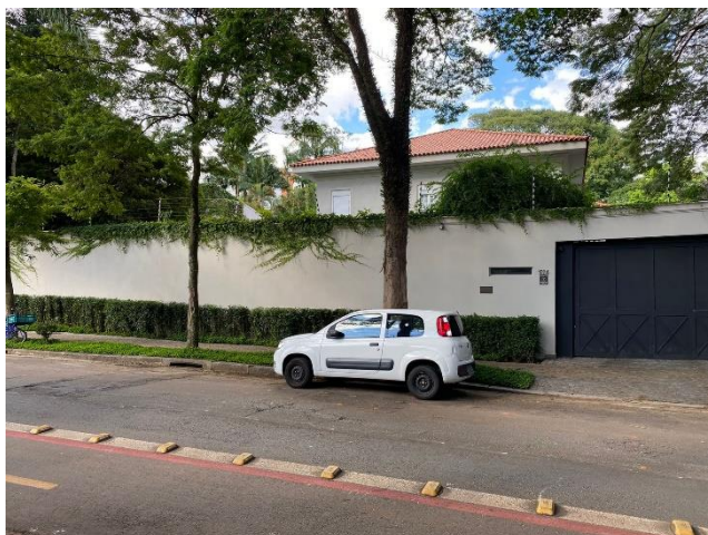
Figura 7: Foto do muro da residência localizada na Rua Honduras
