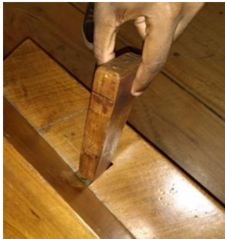
Figura 2. Detalhe da escadaria do MAM-BA: demonstração dos encaixes
