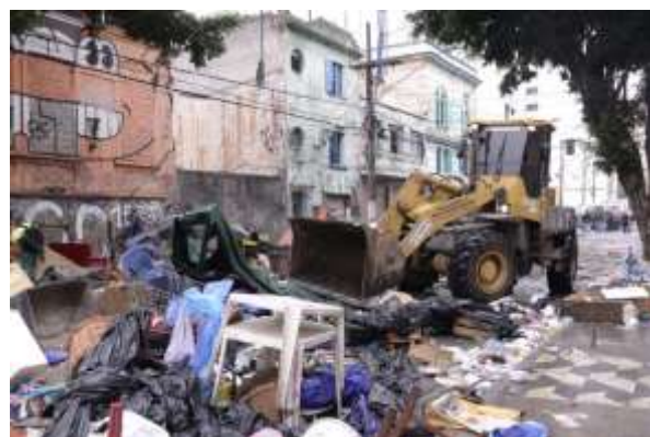
Imagem 10 – Escavadeira em megaoperação
