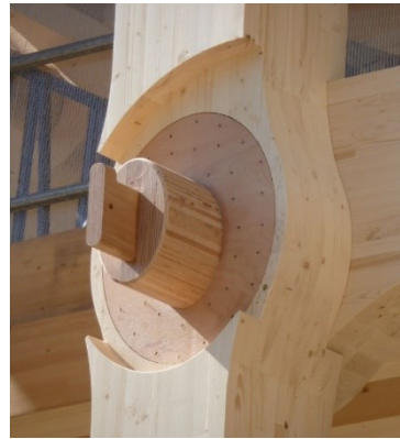
Figura 32: Foto encaixe pilar-viga
