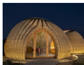
Figura 36: Tecla – Impressão 3D em terra
