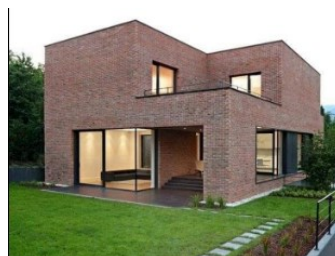
Figura 34: Residência Podfuscak – BTC (Tijolo ecológico)
