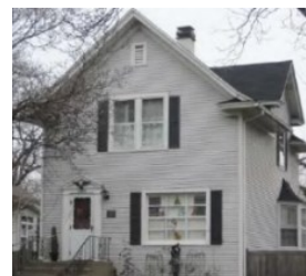
Figura 39: Casa Sears - Wood Frame
