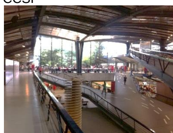
Figura 7. Rampas internas CCSP
