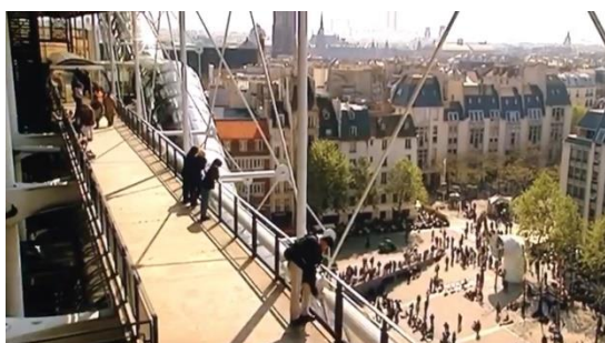
Figuras 14. Passarelas na fachada Pompidou
