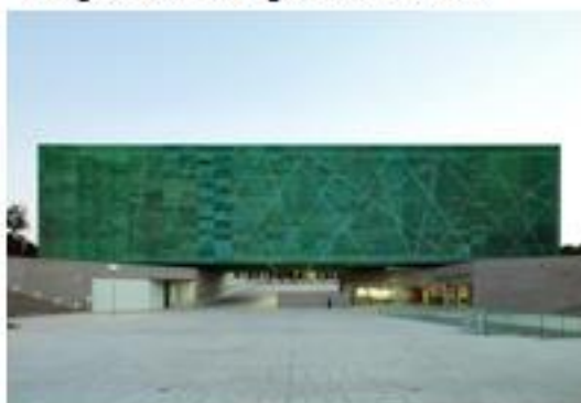
Imagem 02 – Fotografia da fachada
