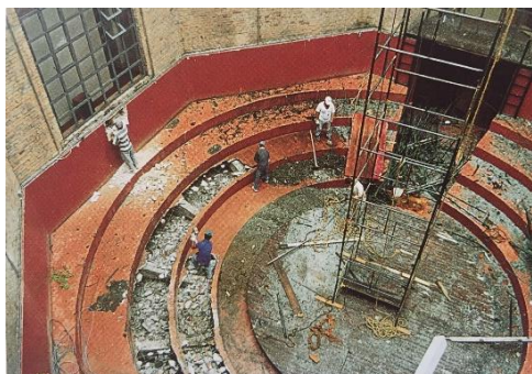
Imagem 3: Desmontagem do antigo espaço Arena
