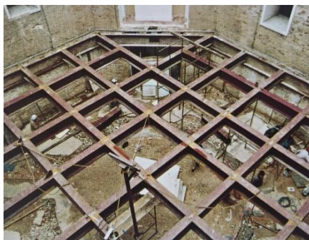
Imagem 4: Construção cobertura do auditório
