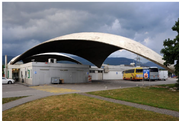
Figura 15: Estrutura de casca da estação de serviço em Dettingen
