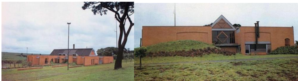
Figuras 04 e 05: Fotografias da obra (Fonte: PROJETO, 2021)
