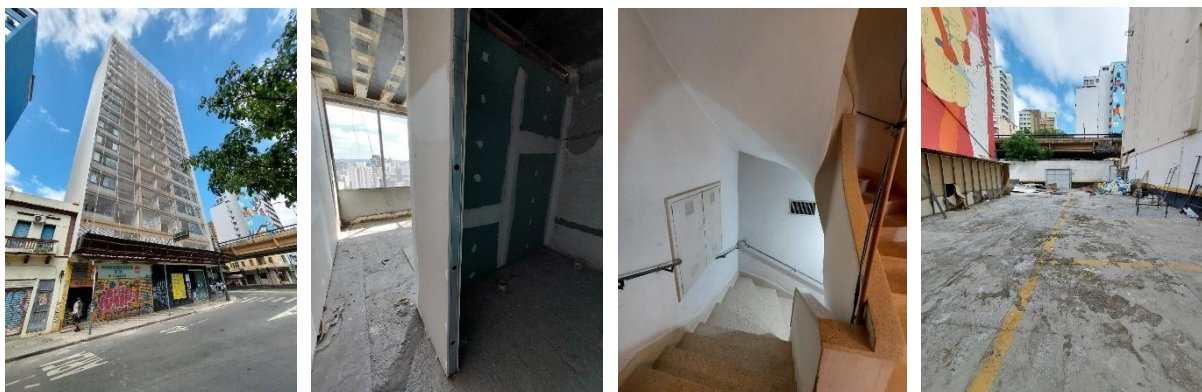
Figuras 5, 6, 7 e 8: Registros da visita. Fachada; Apartamento, onde é possível verificar paredes de drywall e manta de fibra de carbono na laje; Revestimentos preservados na escada; Espaço externo próximo ao Minhocão. Fonte: Autoria própria.
