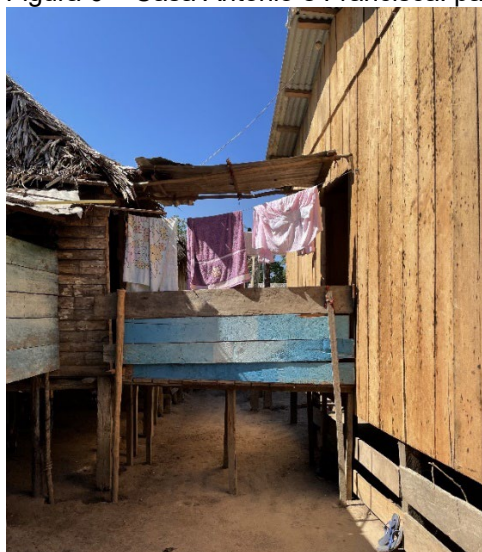
Figura 6 – Casa Antônio e Francisca: passarela de conexão.
