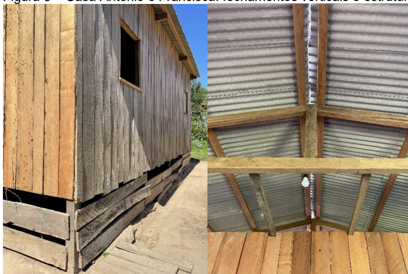
Figura 5 – Casa Antônio e Francisca: fechamentos verticais e estrutura.
