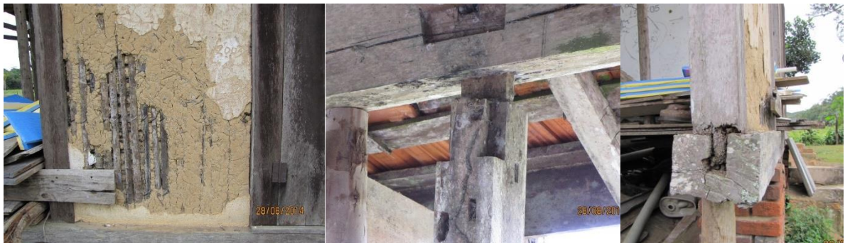
Figura 5 – Detalhes da edificação. À esquerda note-se o uso da taipa de mão construída com técnica japonesa e materiais do local. Ao centro e à direita, note-se as conexões de madeira típicas das construções japonesas. Fotos da autora.
