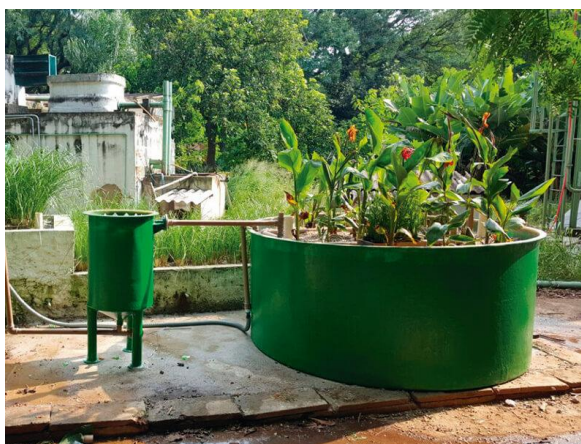
Imagem 4: Sistema de wetlands construído aplicado ao tratamento de esgoto na USP Leste
